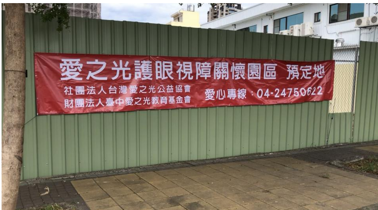
園區預定地整地後樣貌。
